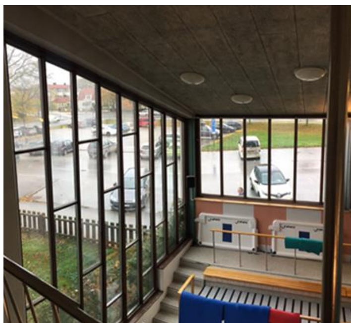
Figur 23. Fönster över hörn.
