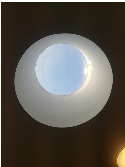
Figur 15. Glaskupol i takfönster.
