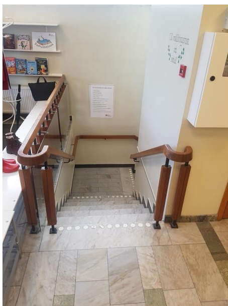
Figur 18. Trappa ner till omklädningsrummen.
